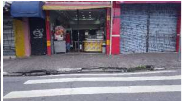
Foto 24 - Travessia sem rampa e podotátil
