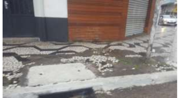
Foto 2 - Caixas de inspeção e calçadas impermeáveis
