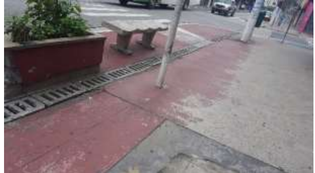
Foto 8 - Grelhas ao longo da Calçada e pisos impermeáveis
